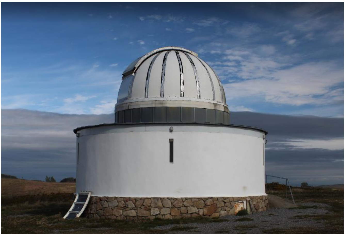
Observatorio Astronómico de Forcarei severamente afectado polos parques eólicos instalados e en tramitación da entorna
