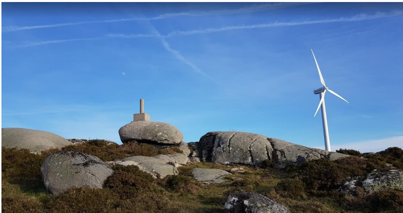
Mirador do Alto de Santa Mariña do Seixo afectado polo parque eólico Serra do Seixo, xa instalado e os demais parques en funcionamento e os que se atopan en tramitación
