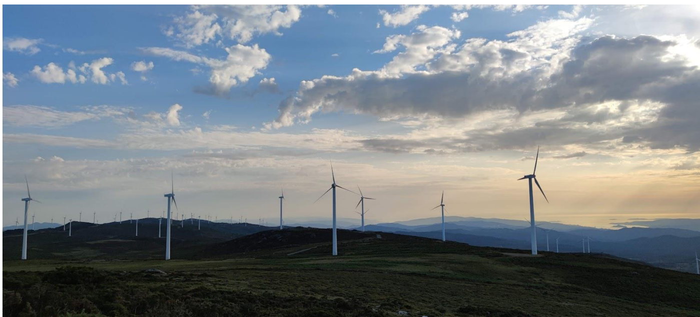
Mirador do Alto de Santa Mariña do Seixo afectado polo parque eólico do Seixo, en funcionamento
