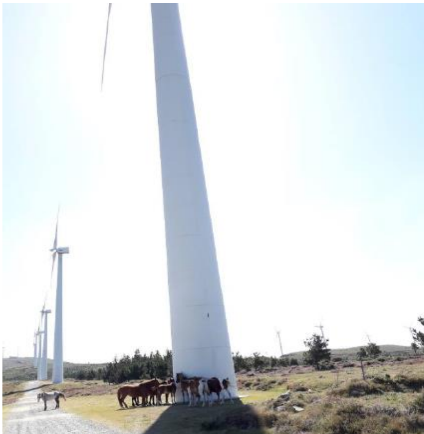
Cabalos salvaxes buscando a sombra dos aeroxeradores. Desertización dos chans a consecuencia das obras das infraestruturas e das cimentacións dos proxectos eólicos.
