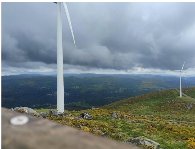
Mirador das Tres Rías afectado de forma severa por infraestruturas eólicas
