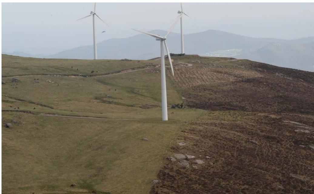
Figura 10.32. La fotografía ilustra un área del LIC-ZEPVN afectada por la construcción de un parque eólico, así como por transformación de una importante superficie de turberas y brezales húmedos a pastizales y plantaciones de Eucalyptus . Fotografía: P. Ramil
