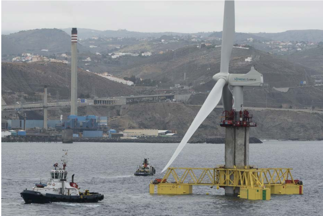
Figura 3.39. Prototipo Elican instalado en 2019 en Gran Canarias. El aerogenerador posee una turbina de 5MW, situada sobre una torre fijada a 30 m de profundidad. El proyecto ha sido ejecuta por el consorcio Elican, liderado por Esteyco y del que forman parte Siemens-Gamesa, Ale Heavylift, Dewi GmbH, y Plocan. Fuente: Elican Project.
