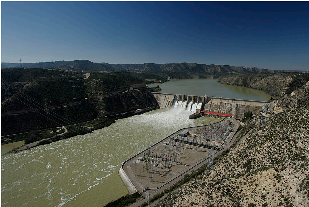
Figura 3.11.- Presa y Central de Mequinenza
