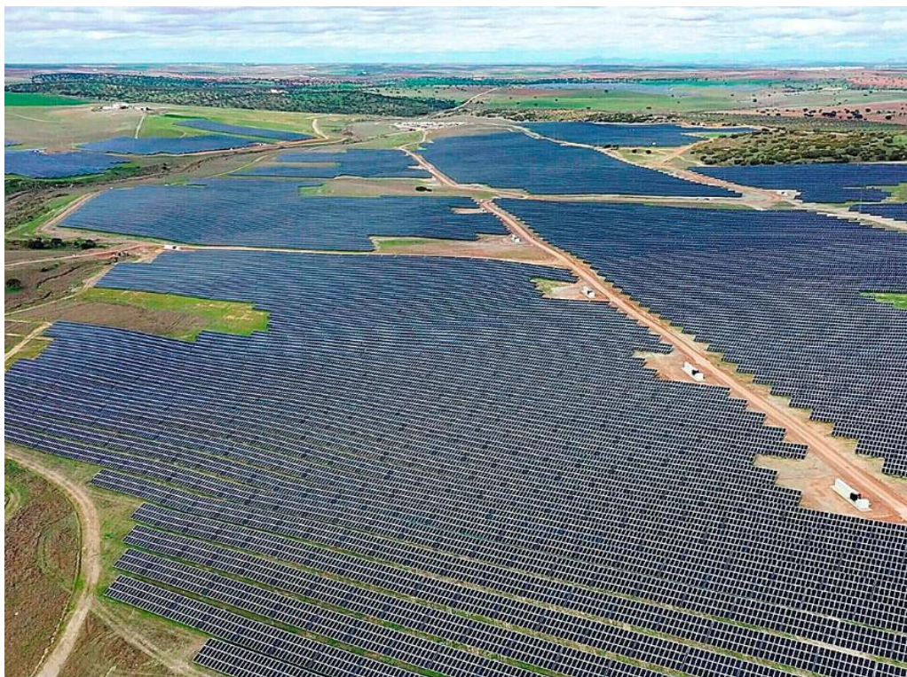
Figura 8.13. Una vista aérea de la Planta Fotovoltaica Núñez de Balboa (Usagre, Badajoz). Fotografía: El Mundo, 15/06/2022
