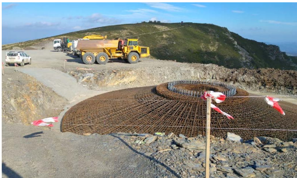
Figura 10.77. Plataforma y cimentación de la torreta de un aerogenerador en el Parque Eólico de la Sierra del Oribio. Las obras fueron paralizadas en 2019 cautelarmente por el Tribunal Superior de Xustiza de Galiza (TSXG). Tribunal que en 2021 finalmente anuló el acuerdo del Consello de la Xunta que sustentaba la ejecución del parque. Fotografía: Fundación Oso Pardo.
