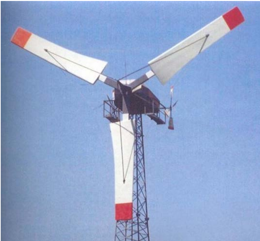
Figura 3.27. Fotografía del aerogenerador Wind Matic 14-55 (WM 14-55), fabricado en Dinamarca por Wind Matic AS. (Diámetro del rotor 14 m. Área del rotor 154 m 2 . Potencia 55 kW), instalado en 1982 en Terras de Soneira (A Coruña). El aerogenerador estuvo conectado a la red desde mayo 1983.
