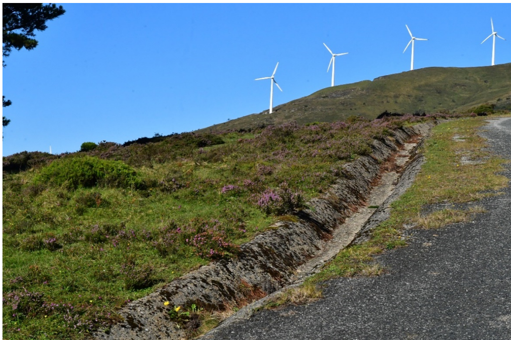
Figura 10.64. Pista de acceso y cuneta cementada de la línea de aerogeneradores ubicada en el Monte del Alto da Cruz (Alfoz, Lugo), en la ZEC Xistral, Zona núcleo de la Reserva de Biosfera.
