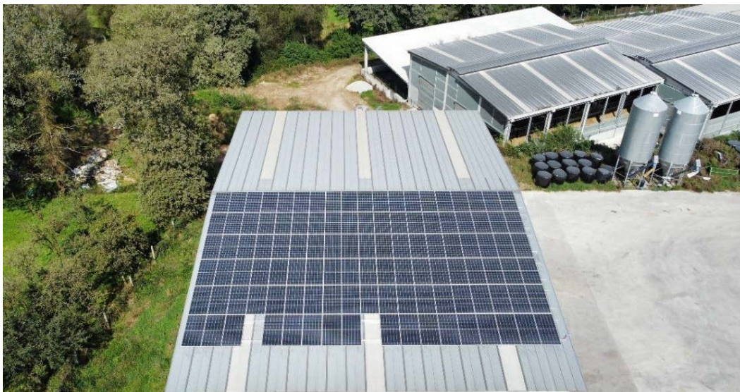
Figura 8.11. Instalación fotovoltaica para autoconsumo (50kw) de una granja en Guitiriz situada sobre las propias instalaciones de la granja, Reserva de Biosfera Terras do Miño. Fotografía; Mecánica Solar, O Saviñao.
