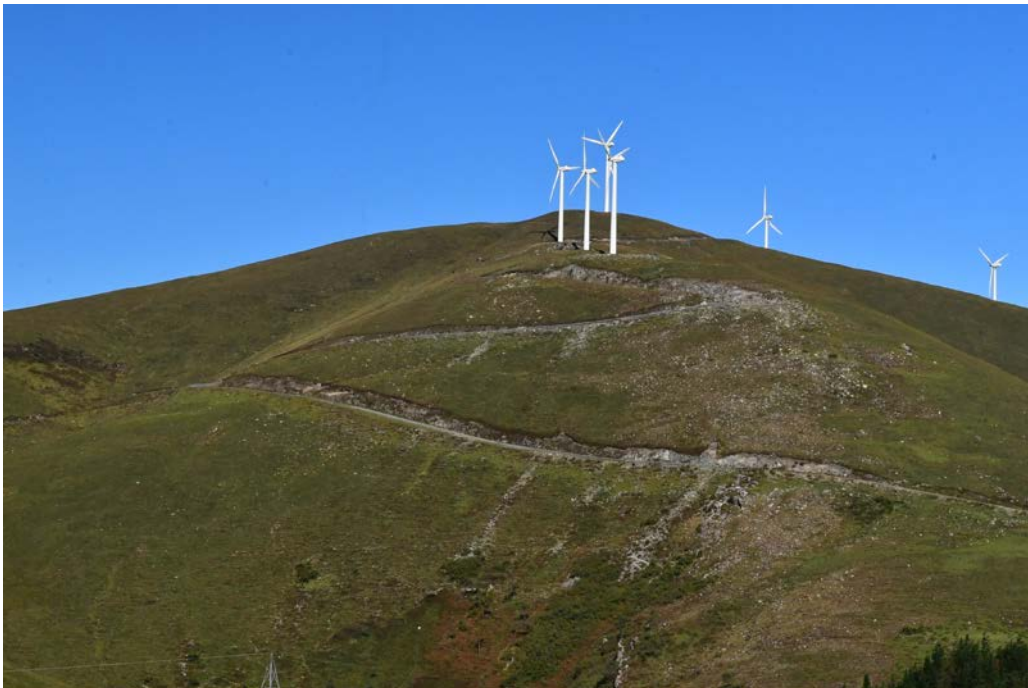
Figura 10.58. Monte Cadramón (ZEC Serra do Xistral), zona núcleo de la Reserva de Biosfera de Terras do Miño. Nótese la erosión generada por el vial de acceso a la línea de aerogeneradores (año 2022)
