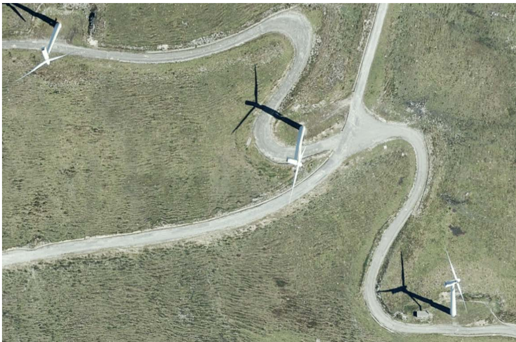
Figura 8.30. Apertura de un vial afectando a humedales de montaña (Nat-2000 7130*, 4020*) en la ZEC Serra do Xistral, Zona Núcleo de la Reserva de Biosfera Terras do Miño. Imagen: PNOA 2020. Imagen superior vista general del área. Imagen inferior: Destalle de un tramo del Parque Eólico
