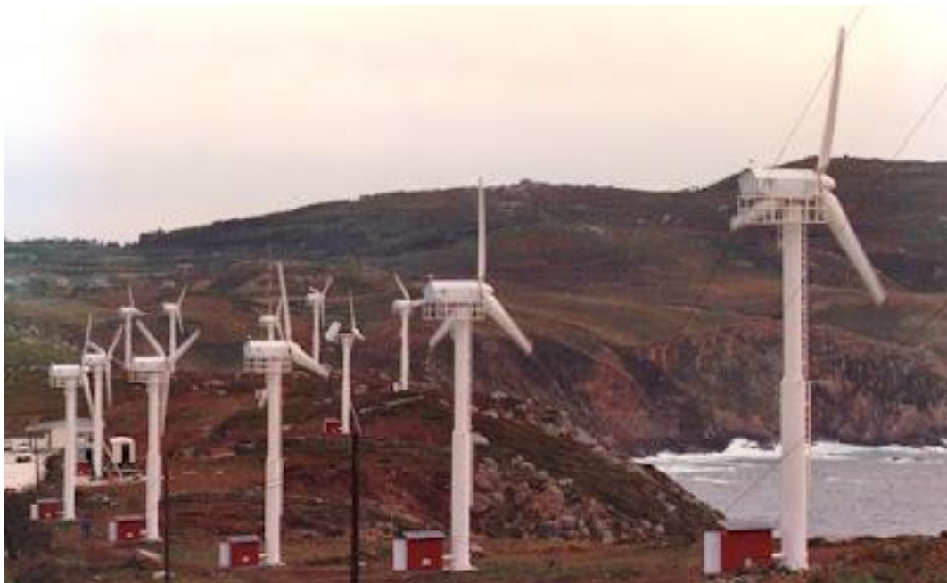
Figura 10.5. Parque Eólico de Estaca de Bares (Mañón, A Coruña). Fotografía: Dinamo. Revista de Ingeniería y Energía.
