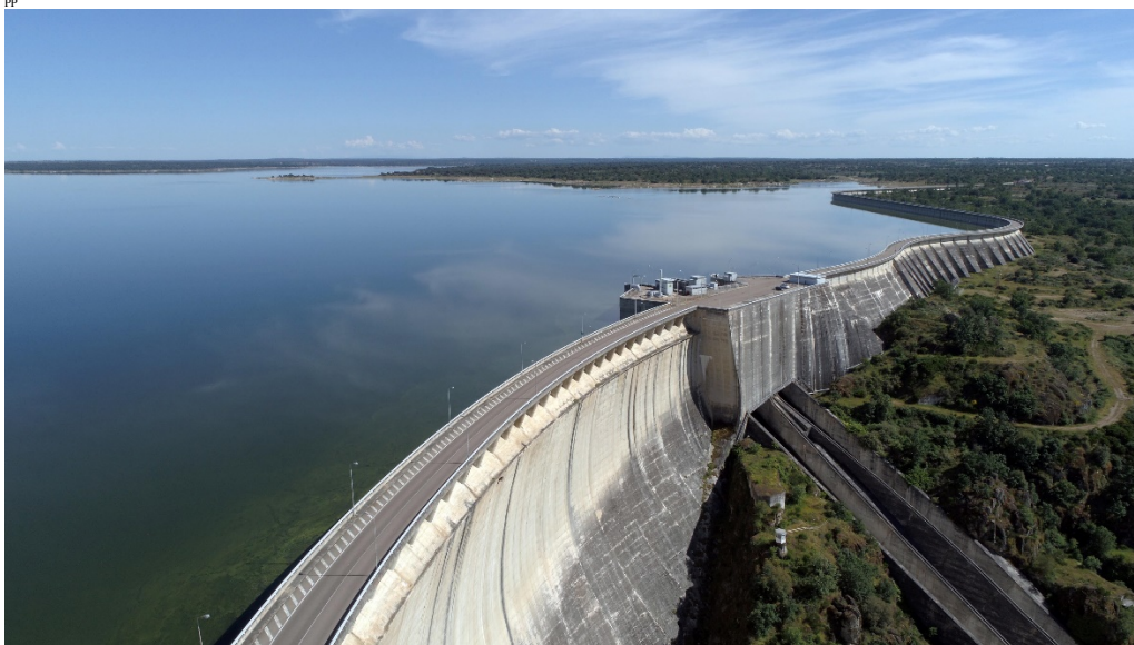
Figura 3.17. La presa de La Almendra, sobre el río Tormes (Fermoselle, Salamanca), es considerada la más alta de España (202 m) y el tercer embalse con mayor capacidad (8.650 ha, 2.649 hm 3 ). La Presa se ubica dentro de la Reserva de Biosfera Meseta Ibérica. Fuente: Ayuntamiento de Fermoselle.
