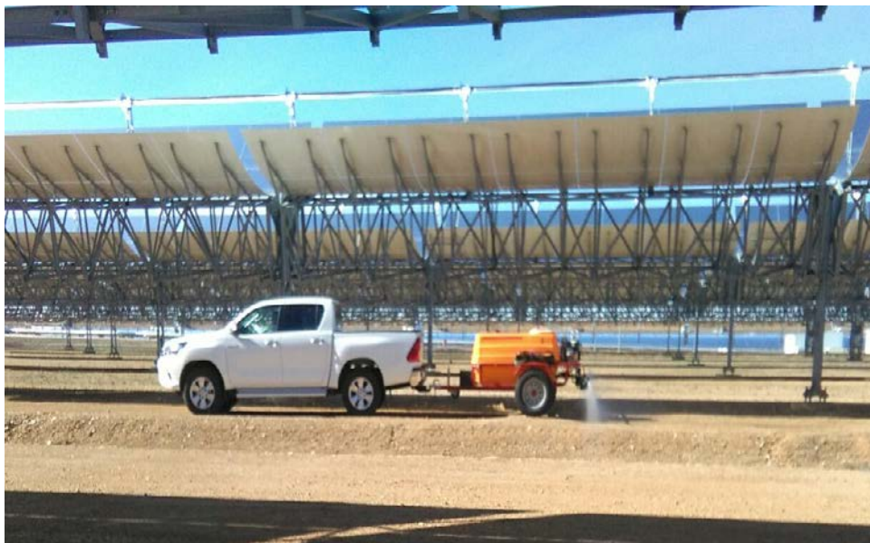
Figura 8.18. Tratamiento de herbicida en una planta termo solar. Fotografía tomada de Servex Ingenieros.
