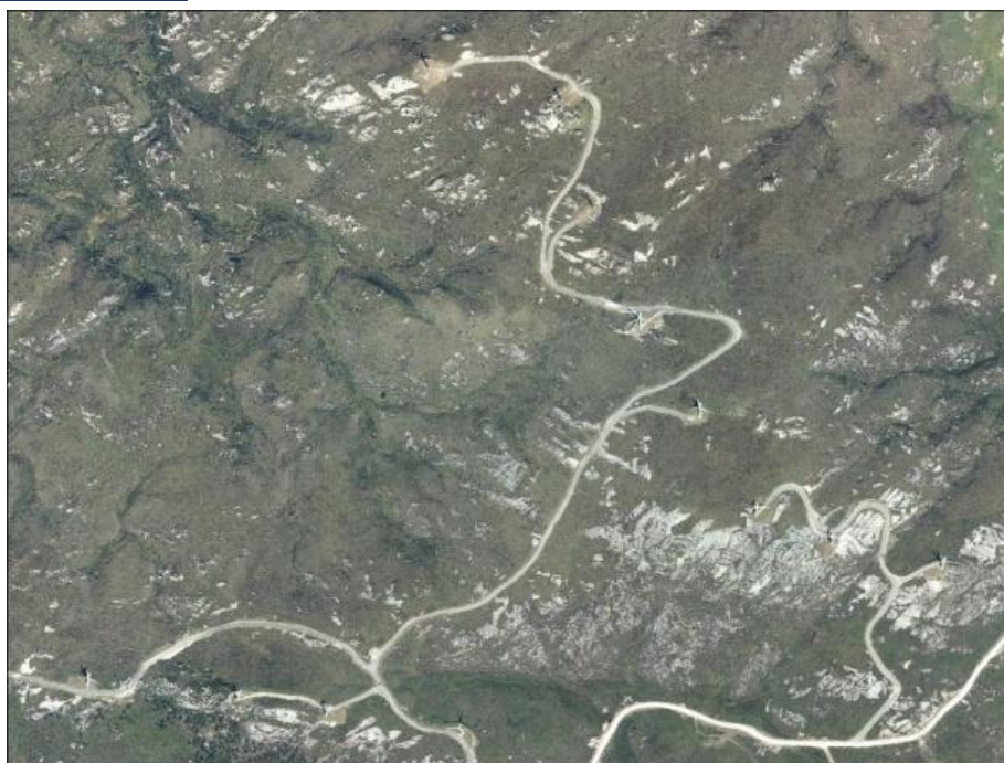
Figura 10.22. Instalación de un parque eólico en la actual ZEC Serra do Xistral (zona núcleo de la Reserva de Biosfera Terras do Miño) sobre turberas altas y, brezales húmedos (Nat-2000 7110*, 4020*), entre 2003 (ortoimagen SIGPAC) y 2011 (ortoimagen del PNOA).
