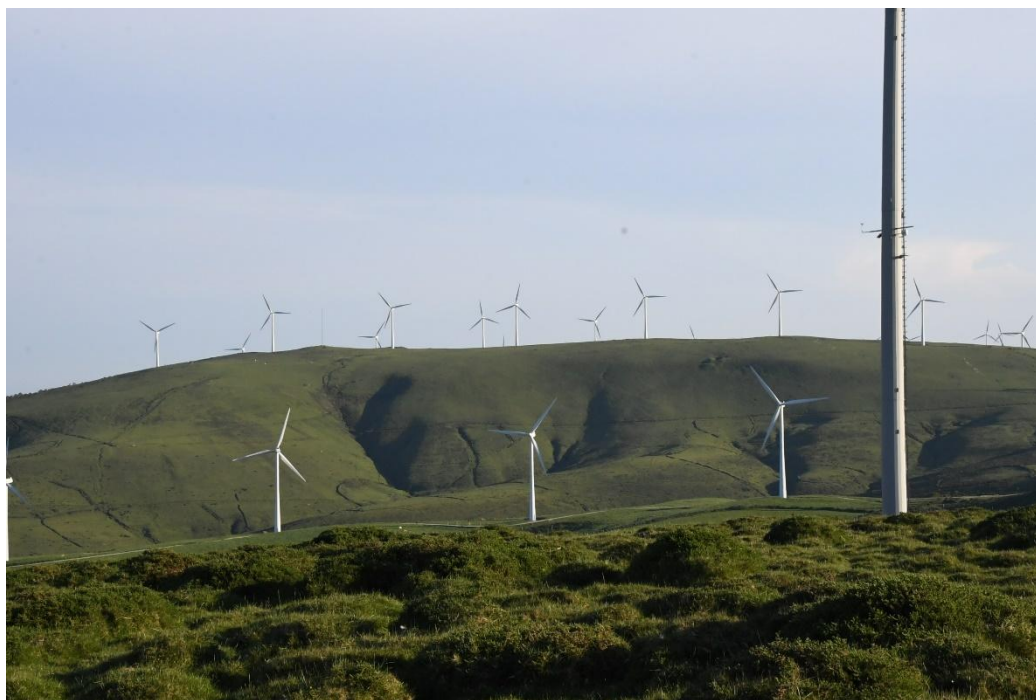
Figura 5.2. Aerogeneradores instalados sobre hábitats prioritarios en la zona núcleo (ZEC Serra do Xistral) de la Reserva de Biosfera Terras do Miño.
